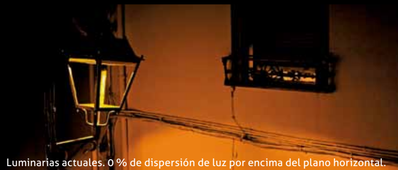
Luminarias antiguas. 35 % de dispersión de luz por encima del plano horizontal.
